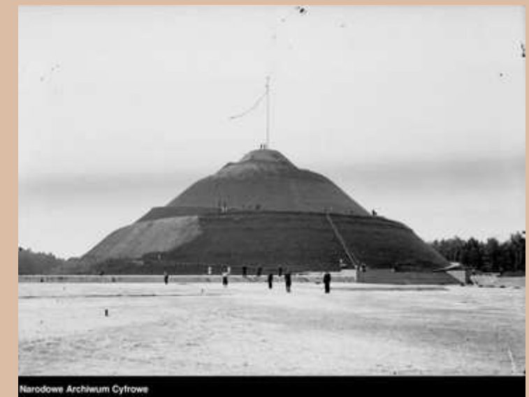
Kopiec po ukończeniu budowy
