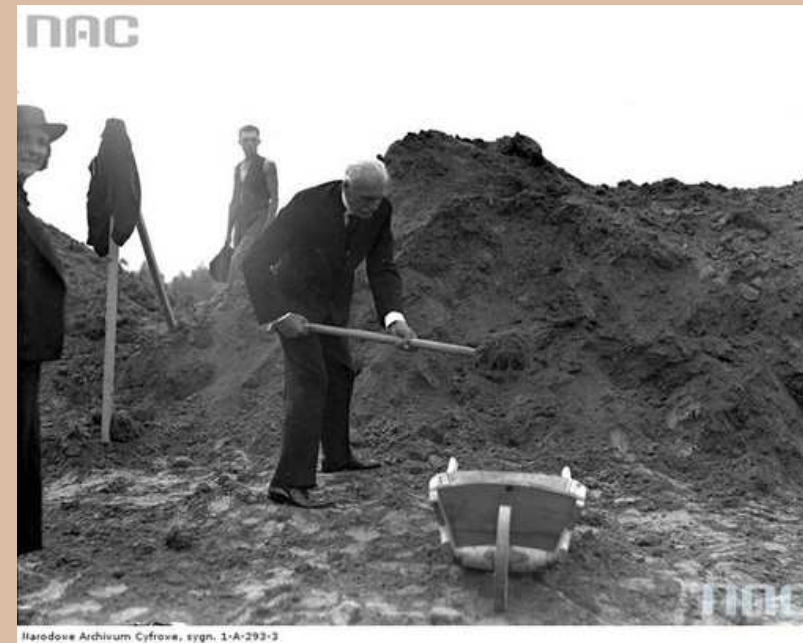
Prezydent RP Ignacy Mościcki podczas budowy kopca na Sowińcu
